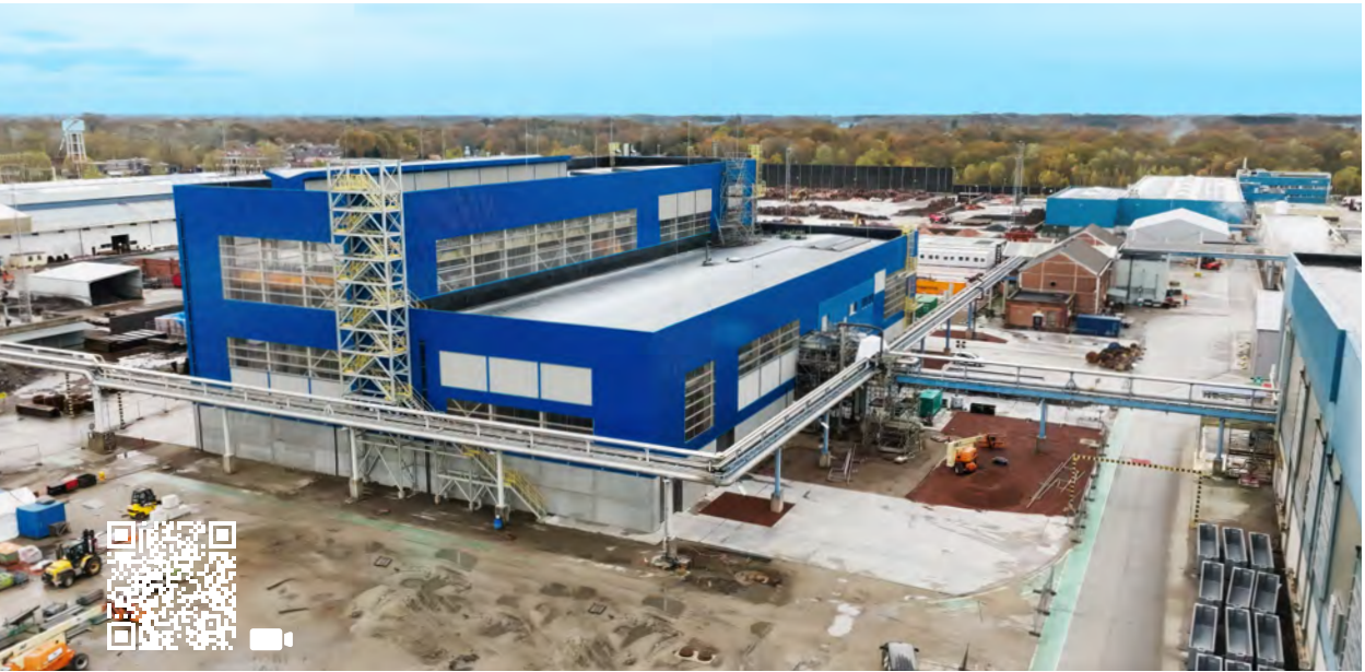
Die neue Anlage im Aufbau Anfang November 2024
